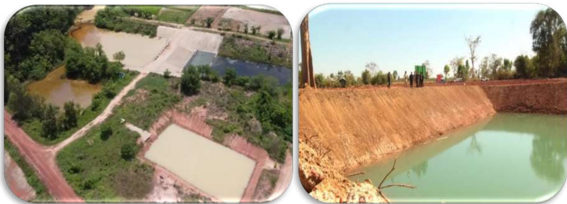
รูปที่ 5-7 ตัวอย่างบ่อธนาคารน้ำใต้ดินรูปแบบเปิด
