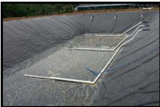
ภาพการใช้ผ้าใบพลาสติกมาปูรองพื้นกันบ่อเพื่อป้องกันการรั่วซึมและช่วยป้องกันการสูญเสียของน้ำ
