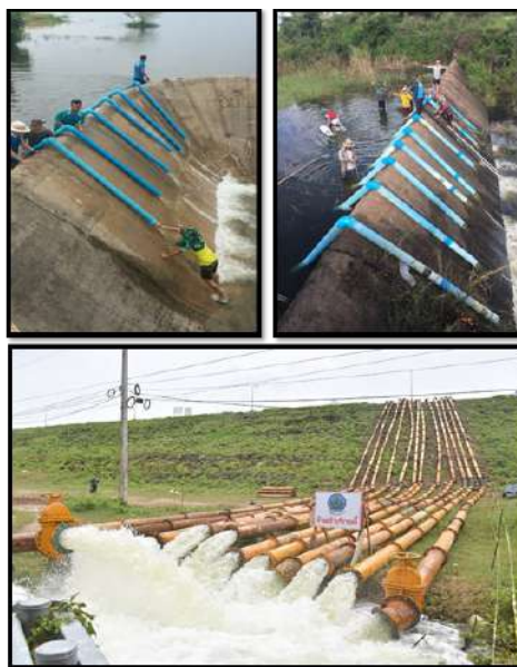
ภาพที่ 15.1.2 แสดงการประยุกต์ใช้หลักกาลักน้ำ มาใช้ในการแก้ไขปัญหาหน้าท่วมและน้ำแล้งในพื้นที่
