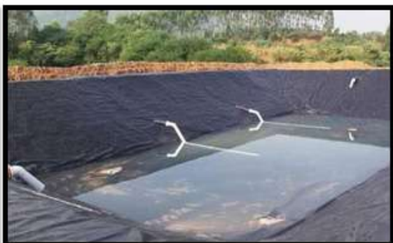
ภาพการใช้ผ้าใบพลาสติกมาปูรองพื้นกันบ่อเพื่อป้องกันการรั่วซึมและช่วยป้องกันการสูญเสียของน้ำ
